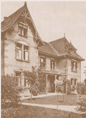
Südseite eines Stationsgebäudes, um 1910
