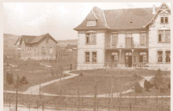
Zwei Stationsgebäude von Süden gesehen, um 1905
