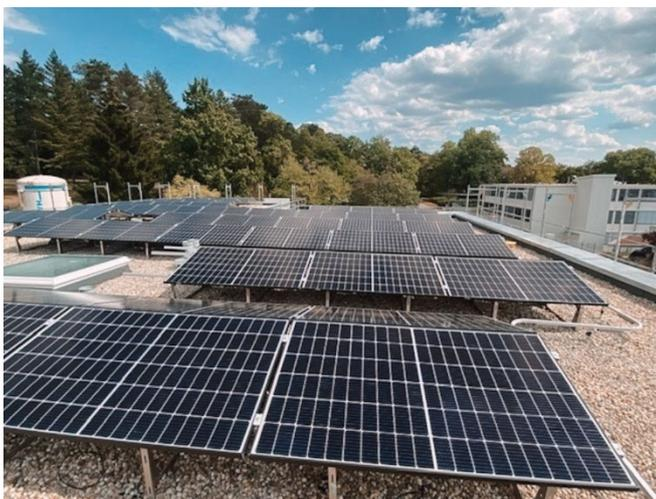
*Insgesamt 75% der Dachfläche der Clearing- und Kriseninterventionsstation wurde mit Photovoltaik-Paneelen bestückt. Die 270 Paneele erzeugen etwa 66 Kilowatt-Peak und werden als*
